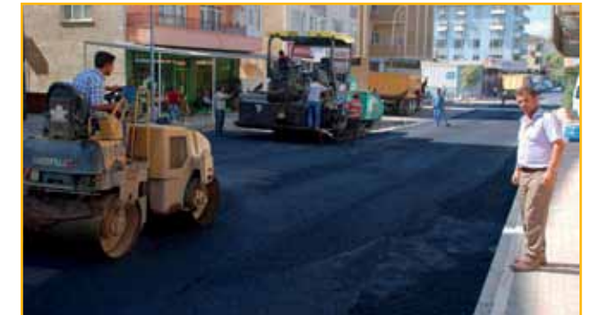
İstanbul Tuzla Belediyesi, bir yılda 120 bin ton asfalt serimi yaptı. Belediye son olarak, İçmeler Mahallesi'nde 1 haftada 1020 tonluk asfaltlamanın yanı sıra kilit taşı, bordür döşemesi ve yağmursuyu kanal çalışmalarını da tamamladı.
