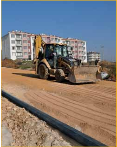
Bursa İnegöl Yeniceköy Belediyesi Başkanı Hasan Aksu ve Fen İşleri Müdürlüğü yetkilileri, kasabanın çeşitli yerlerinde yapımı tamamlanan ve devam eden çalışmaları yerinde inceleyerek bilgi aldı.
