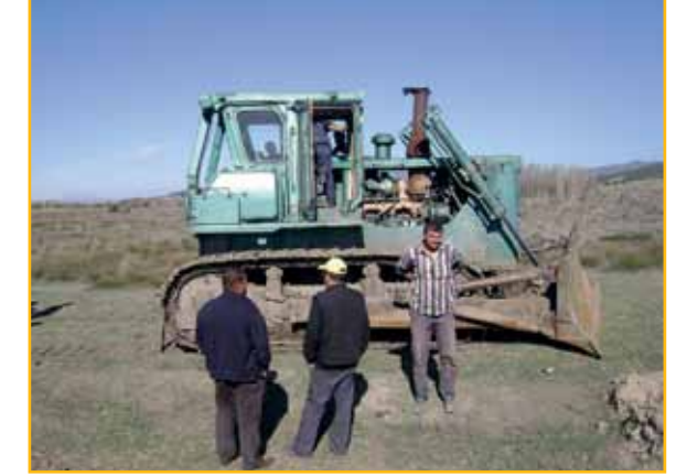
Burdur Gölhisar Yusufça Belediyesi, Yusufça Ovası'nda Devlet Su İşleri tarafından yapılan drenaj çalışmalarının devam ettiğini bildirdi.
