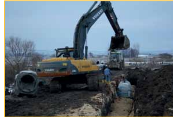
Kırklareli Vize Belediyesi, ilçenin tümünü kapsayacak altyapı çalışmalarına başladı. Düzova Köprüsü'nden başlayan çalışmalarda, 600'lük beton boru döşendi ve belirli noktalarda bacaları yerlerine koyan ekipler, 250 metre uzunluğunda yol aldı.
