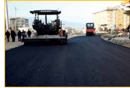
Antakya Belediyesi Fen İşleri Müdürlüğü ekipleri Ekinci Kavşağı, Hüseyin Özbuğday Lisesi, Türkmenpaşa Caddesi ile Altınçay, Saraykent, Ürgenpaşa, Aksaray Mahallesi'nde yıpranmış yollarda asfalt yama ve kaldırım onarma çalışmaları yaptı.
