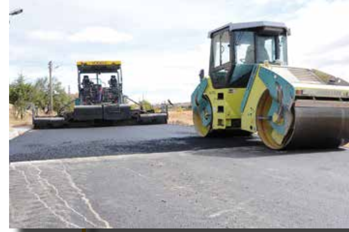
Kırşehir Belediyesi'nin sıcak asfalt çalışmaları devam ediyor
