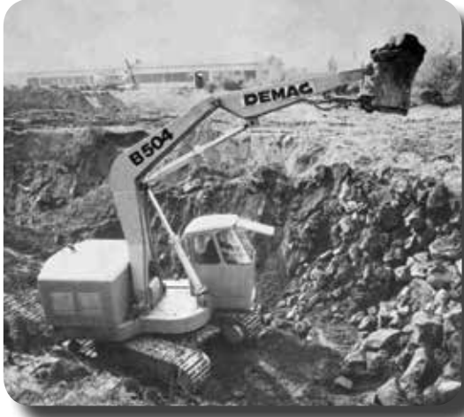
Demag B504 Dünyanın ilk dizel motorlu tam hidrolik paletli ekskavatörü - 1954
