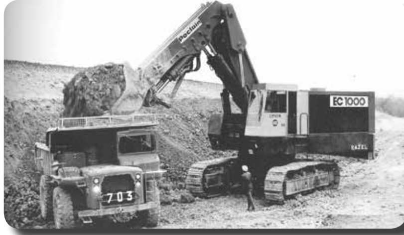
Poclain EC1000 3 dizel motoru ile 1.000 hp güce sahip devrinin en büyük makinesi - 1969
