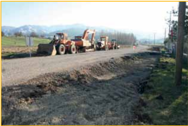
Kastamonu İhsangazi Belediyesi'nin girişimiyle ilçe girişinde yol genişletme çalışmaları başladı.
