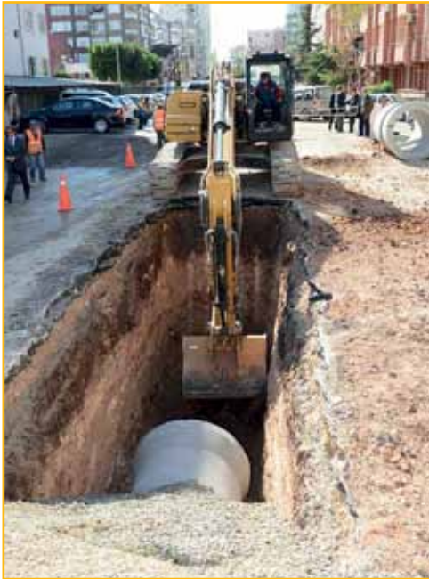
Adana Büyükşehir Belediyesi'nin Baraj Yolu'nu Göğüs Hastanesi Kavşağı'na bağlamak için yapımına başladığı Altın Bulvar'ın devamında ASKİ Genel Müdürlüğü tarafından yapılan altyapı çalışmalarında bulunuldu.
