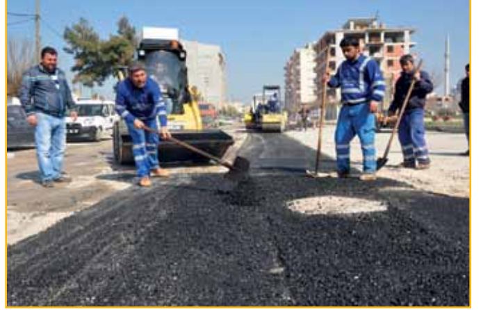
İzmir Torbalı Belediyesi, asfalt çalışmalarına başladı. 1 günde 700 ton asfaltın döküldüğü bildirildi.
