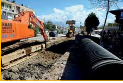
İzmir Büyükşehir Belediyesi, İnönü ve Yeşillik Caddesi arasındaki 4,5 kilometrelik ekspres güzergah için yapım çalışmalarına başladı.
