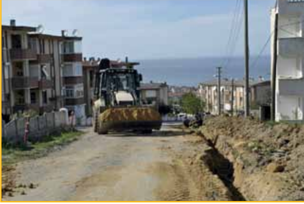
Yalova Çınarcık Belediyesi ekipleri, Hasanbaba'da doğalgaz çalışmalarına başladı.
