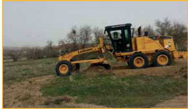
Nevşehir Ürgüp Belediyesi 370 Evler Mahallesi, yeni terminal yoluna giden ana cadde, Belediye Toplu Konutları ile Ahmet Yesevi Camii arasındaki imar yolunun açılması için zemin çalışmaları yaptı.
