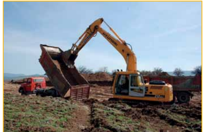
Kütahya Gediz Belediyesi tarafından Umurbey Mahallesi'nde yeni okul binası yapımına başlandı.
