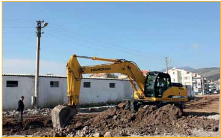
İzmir Dikili Çandarlı Belediyesi, deniz seviyesinin altında kalan bölgelerde sağanak yağmurlarda su taşkını olmaması için çalışmalarına bir yenisini ekleyerek "Taşıma Kanalı" yapımına başladı.
