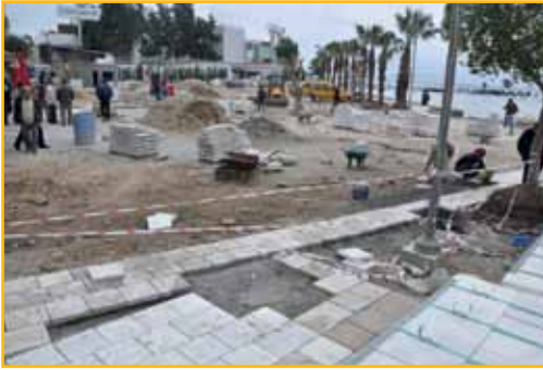
Muğla Bodrum Belediyesi, Kumbahçe Meydanı'nda mermer döşeme çalışmalarına başladı.
