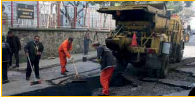
İstanbul Bakırköy Belediyesi Fen İşleri Müdürlüğü'nden yapılan açıklamaya göre; ilçe bazında 299.284 asfalt serimi gerçekleştirildi, 3606 yol bariyerinin yapıldı ve 3366 metre küp beton serildi.
