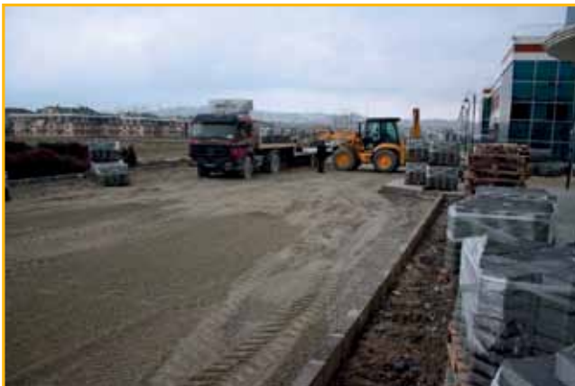
Adapazarı Arifiye Belediyesi, kent merkezine yaptırılan Kültür Merkezi'nin etrafındaki yolları açtı. Caddeler arasındaki bağlantı noktaları taşlarla döşendi.
