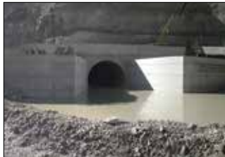
Tünel çıkış yapısı
